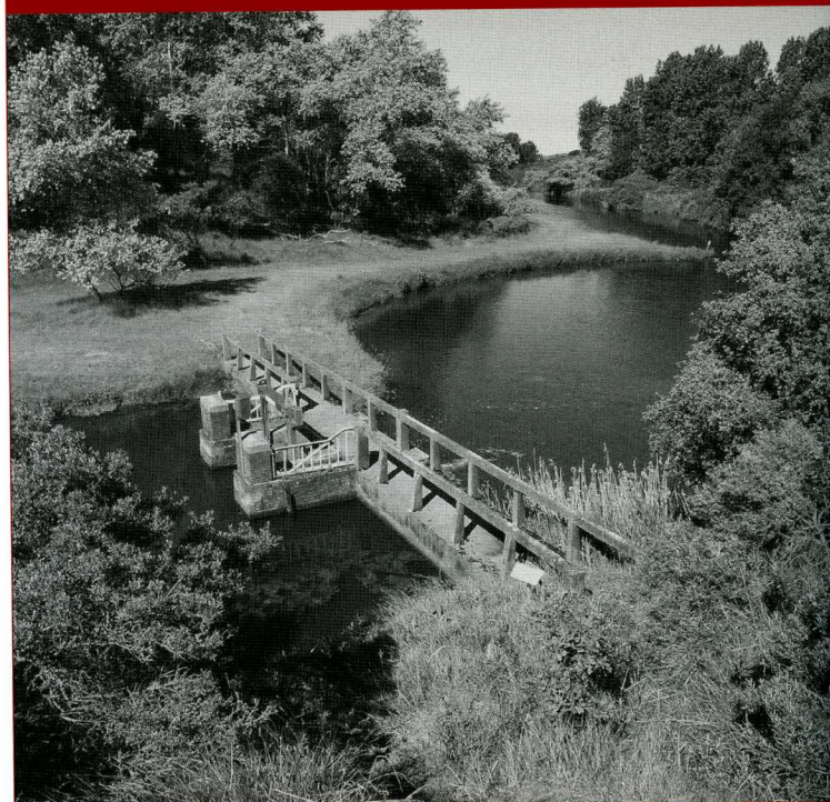
Stuw in Korte Barnaartkanaal, vlak bij knooppunt met en brug over Noord-Oosterkanaal bij ingang Zandvoortselaan (nog in functie) Foto: Harm Botman
